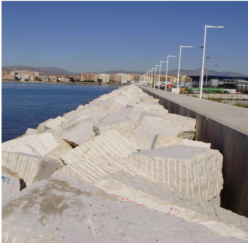
*Fig 5: Bloques de mármol colocados en el contradique Ampliación puerto de Alicante*
